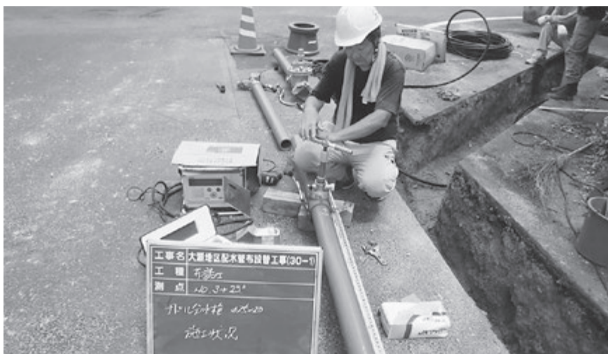
送配水管の工事
