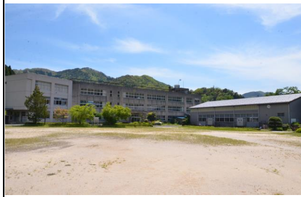
校舎等の外観写真
