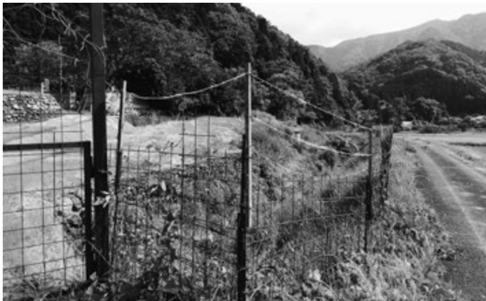
八頭町日田地区のフェンス（高さ1.0mの上にワイヤーを張っている）
