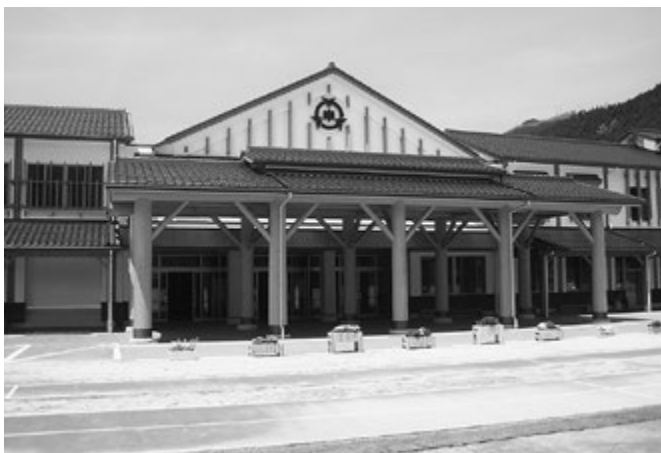
智頭中学校 (木造建築)
