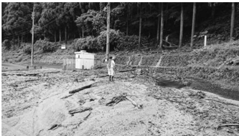
用水路土砂流出
