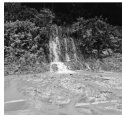
土砂流出の現場
