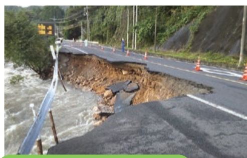
平成30年9月30日 台風24号 (国道179号 久原～曹源寺間)
