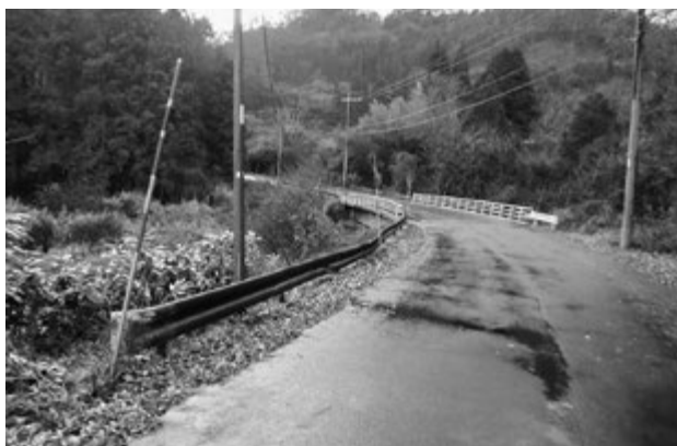
町道の様子（福本橋付近）
