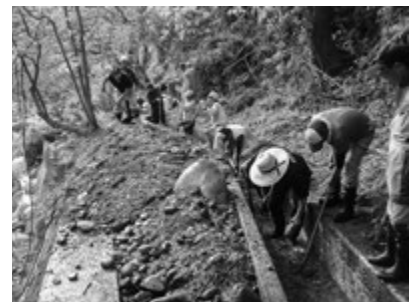
水路の維持管理作業
