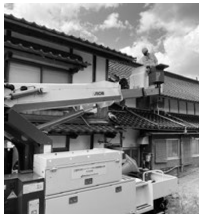
光ケーブル宅内切替工事
