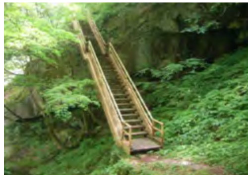
写真3 小鹿溪遊歩道
