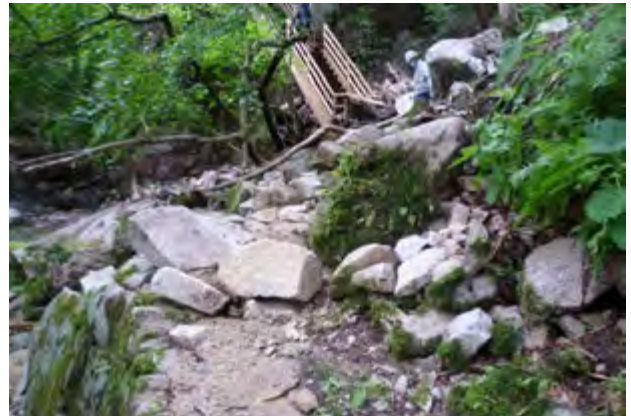
写真20 被災直後の遊歩道（令和3年7月）
