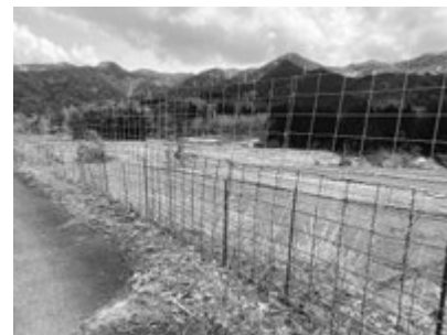
シカ対策防護柵
