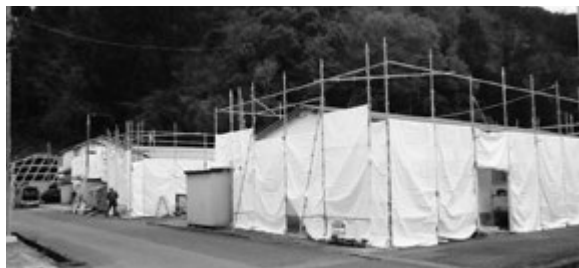
町営住宅改修の様子
