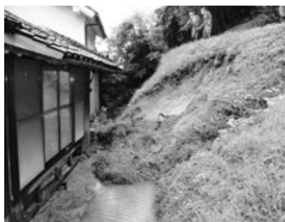
災害により壊れたがけ地
