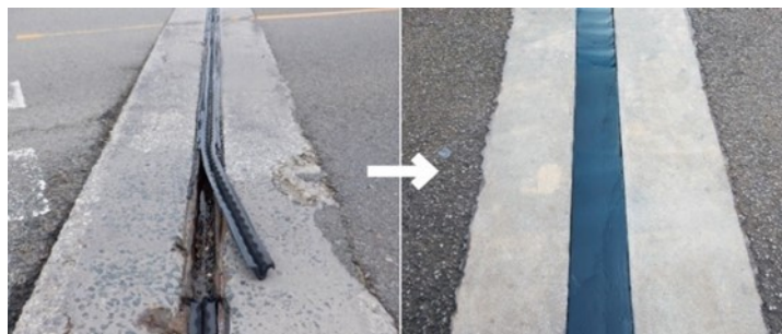
「ゴム劣化取替工法」【NETIS QS-180049-A】
