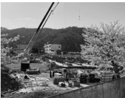
建設が進む小学校新校舎
