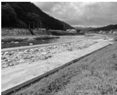
台風7号の被害
