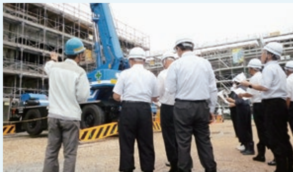
三朝小学校の新築工事の視察を行いました
