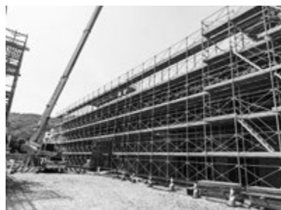
建設が進む小学校校舎
