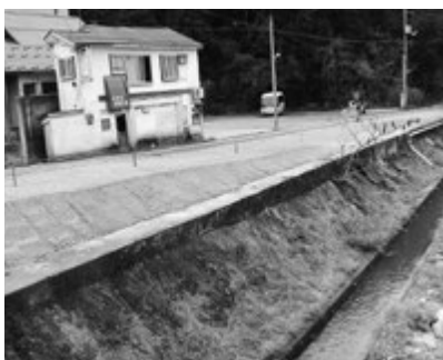
護岸改修予定地
