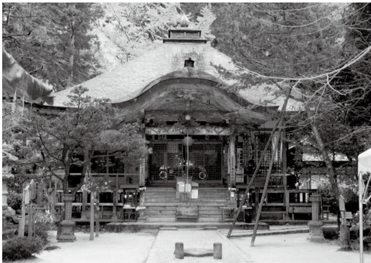
1 三佛寺本堂（平成16年12月撮影）
