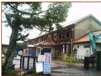
「ヨーコ」解体 (旧旭中学校舎)
