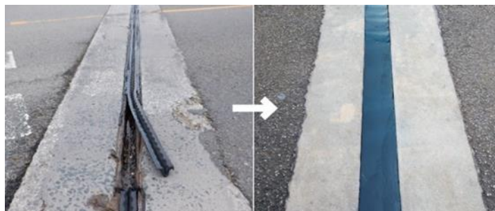
「ゴム劣化取替工法」【NETIS QS-180049-A】
