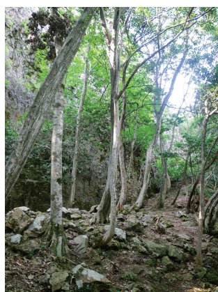
写真6 冠巖裾と人工平場 法面に三段にわたり土留め石積が行われている。
