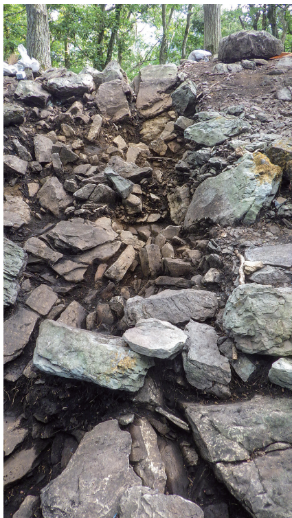
写真103 南側土塁北面トレンチ全景（北側裾から） 手前側の石積は石組遺構1主室（室）を構成する南面の石組。
