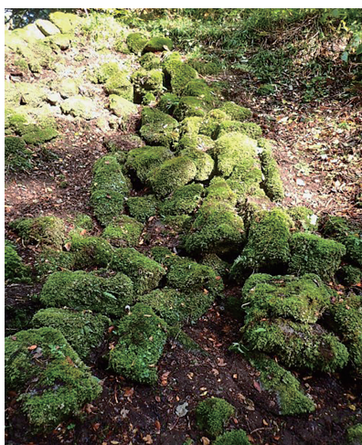
写真90 大山南光院谷氷室（雪穴）内隅の石組
