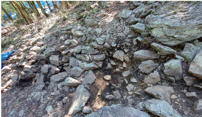
写真108 南側土塁南北トレンチ南面土層断面 図96の1・2段目に該当し、左側に見えているのが土留1と2の石積み。
