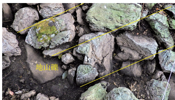
写真101 断面部南側土留 土留石列 地山礫上に地面の傾斜に合わせて石列を設けている④
