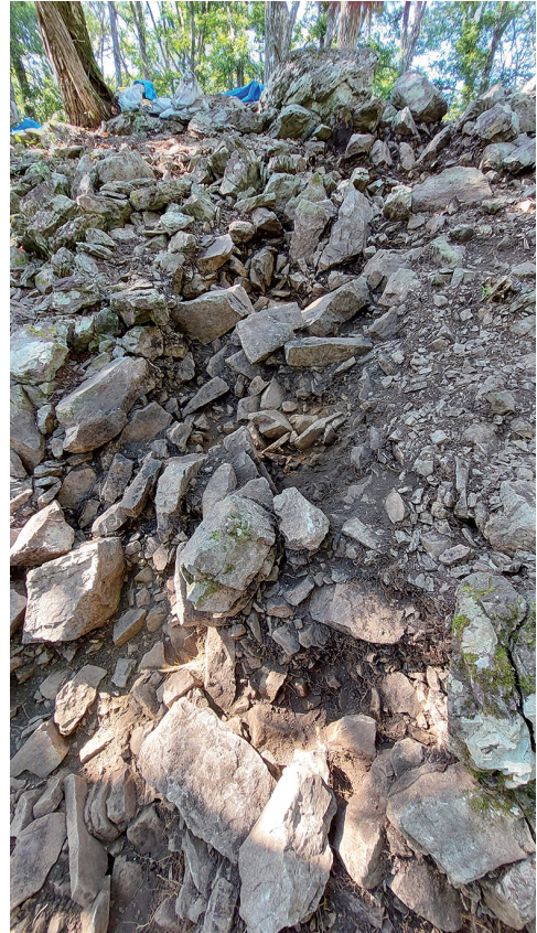
写真107 南側土塁南北トレンチ南面全景 (南側裾から) 数段に及ぶ土留め石列を見ることができる。
