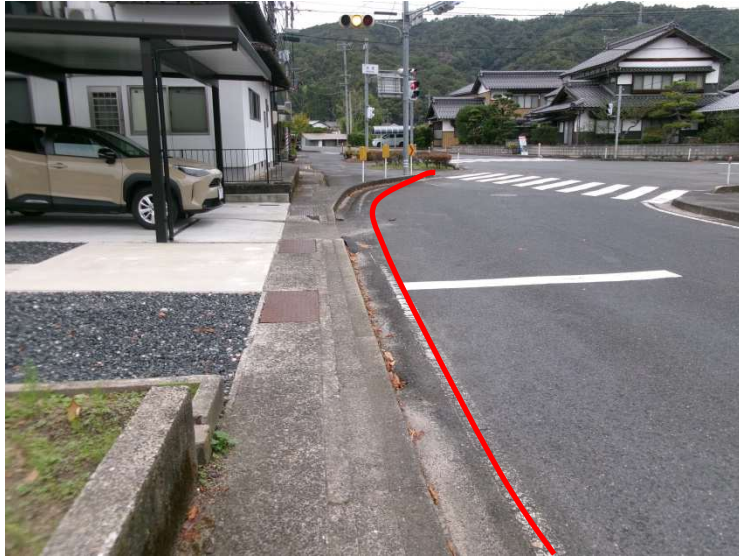
本泉交差点から終点側の車止めまで、歩道横に外側線を引く（BP～EP、全長 473m）
