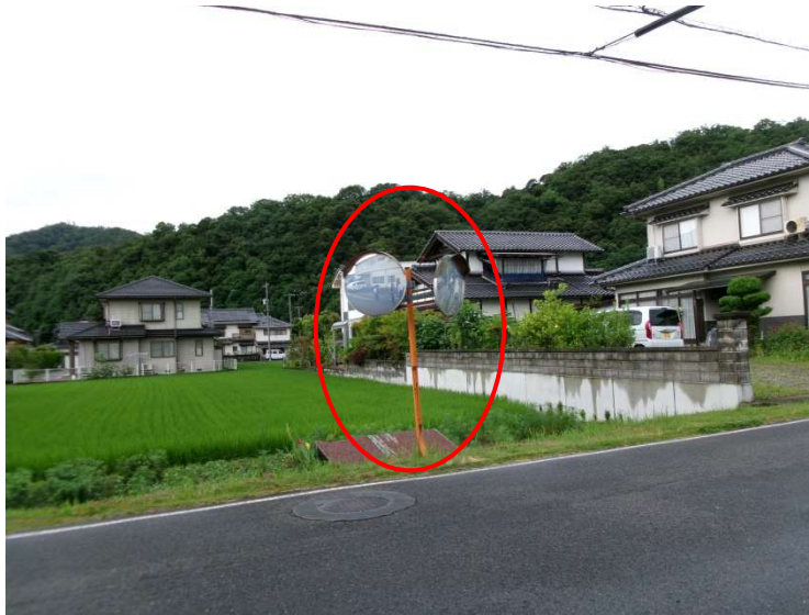
町道大瀬本線と町道金盛線との丁字路。既設二面鏡を更新
