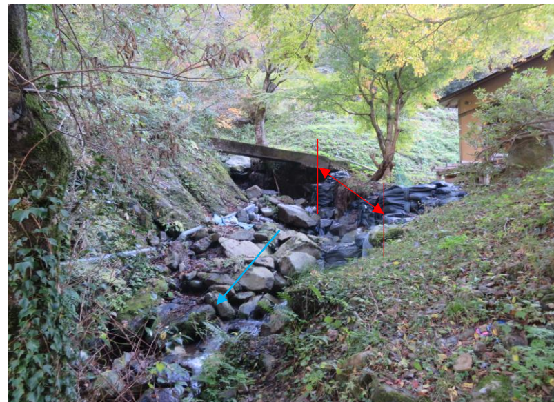
護岸整備 L=16.0m
