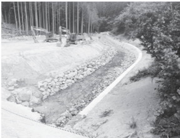
加茂川河川災害復旧工事
