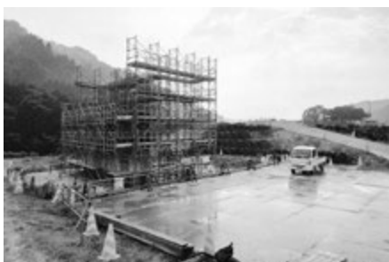
工事が始まった坂本バイパス
