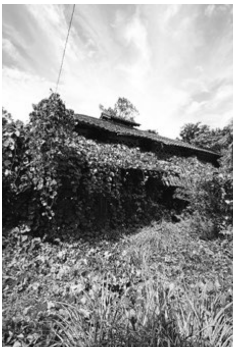
放置された空き家
