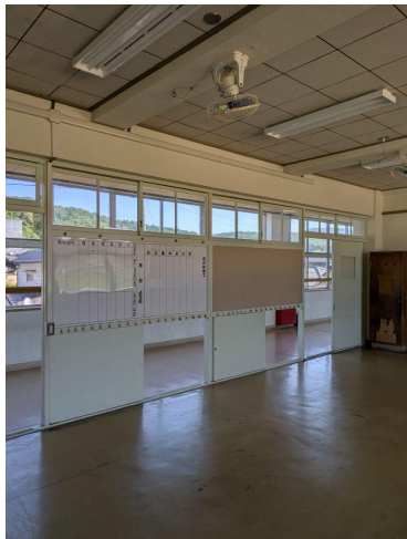
教室廊下側(2階)
