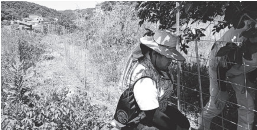
ワイヤーメッシュ柵の設置
