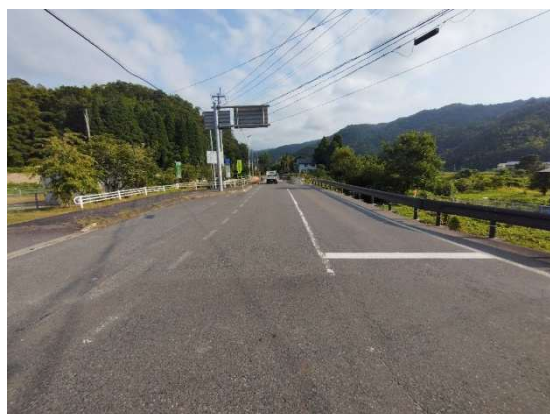
ランナーの進行方向から見た片柴橋
